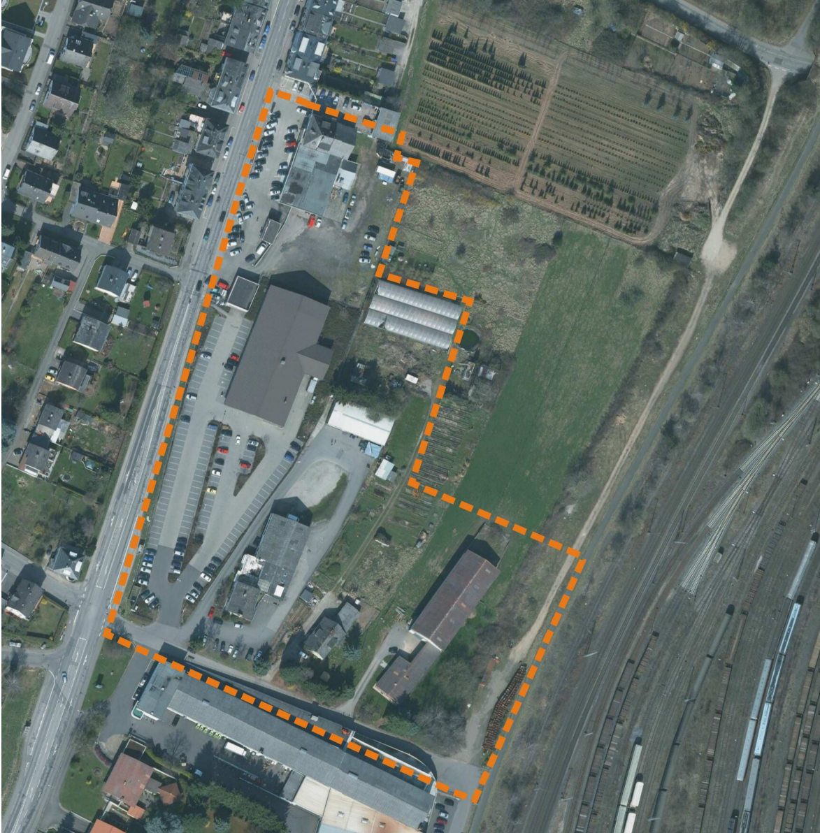
Abbildung 1: Luftbildaufnahme des Plangebietes (2009)
