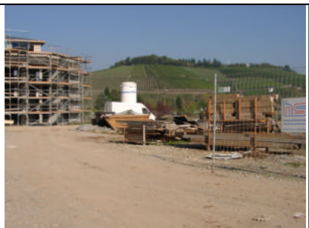
Blick von Südwesten
